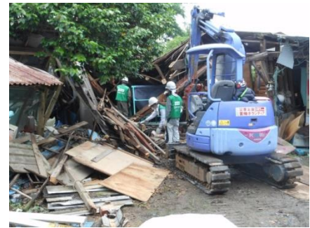
瓦礫搬送に必要なダンプの貸出や解体ハンマー、フレキシブルコンテナバックの供与を行いがれき撤去のサポートを行いました。
