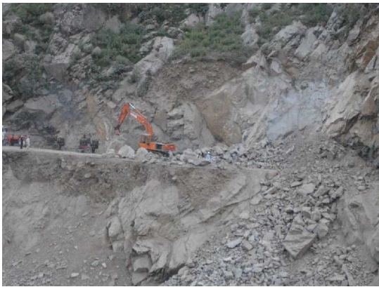
水害から 2 ヶ月経っても道路復旧のための工事が続いている
