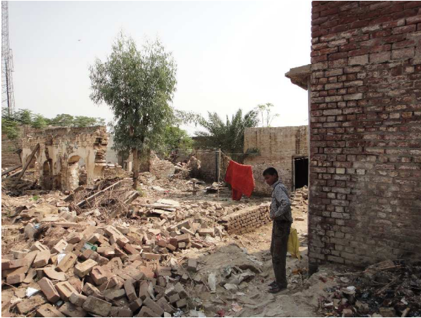
洪水で崩壊した家屋
