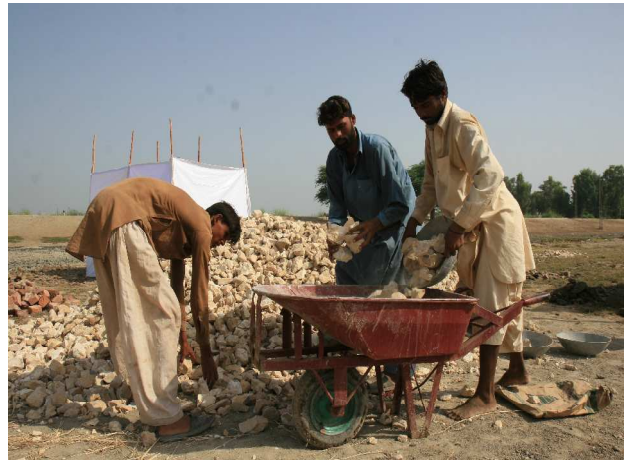
「キャッシュ・フォー・ワーク」プログラムでトイレを建設
