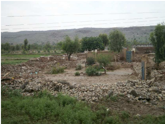
水害直後の被災地。建物が崩れがれきの山となっている（コハート県）
