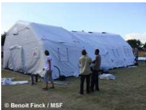
ポルトーフランスでのテント病院の設置
